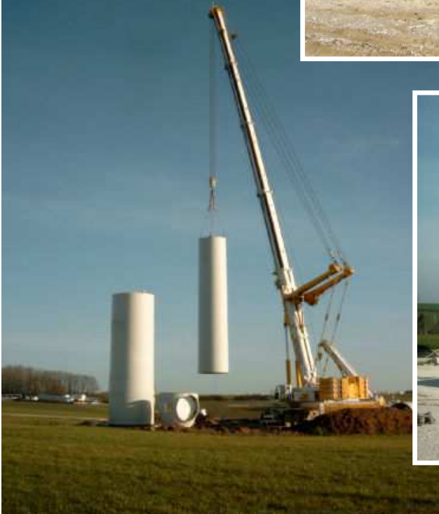
Assemblage des tronçons de mât
