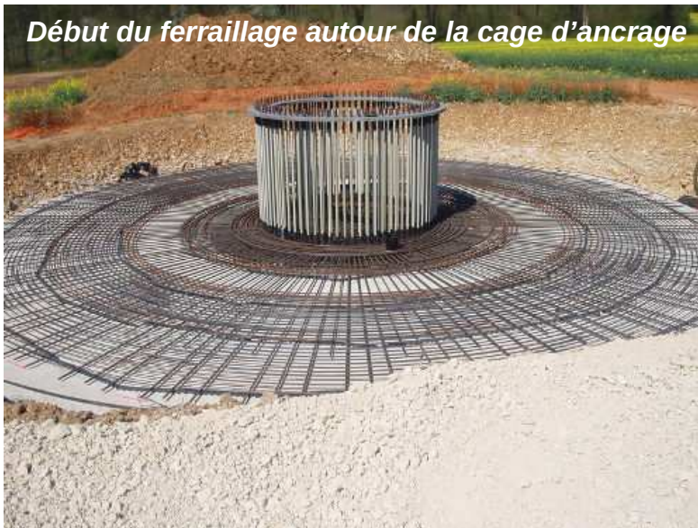
Cage d'ancrage servant de virole
