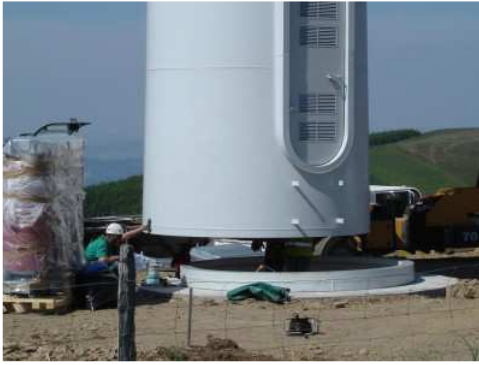
Assemblage des tronçons de mât
