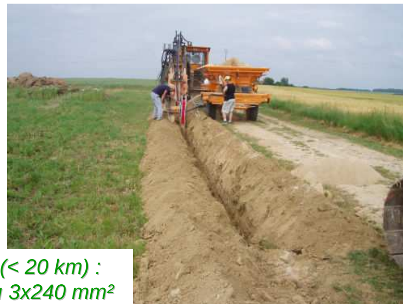
Enfouissement câbles : 0,5 à 1 m de profondeur
