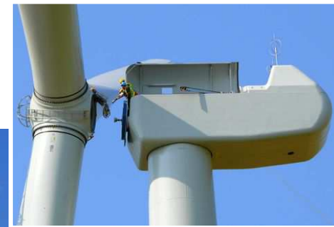
Assemblage du rotor
